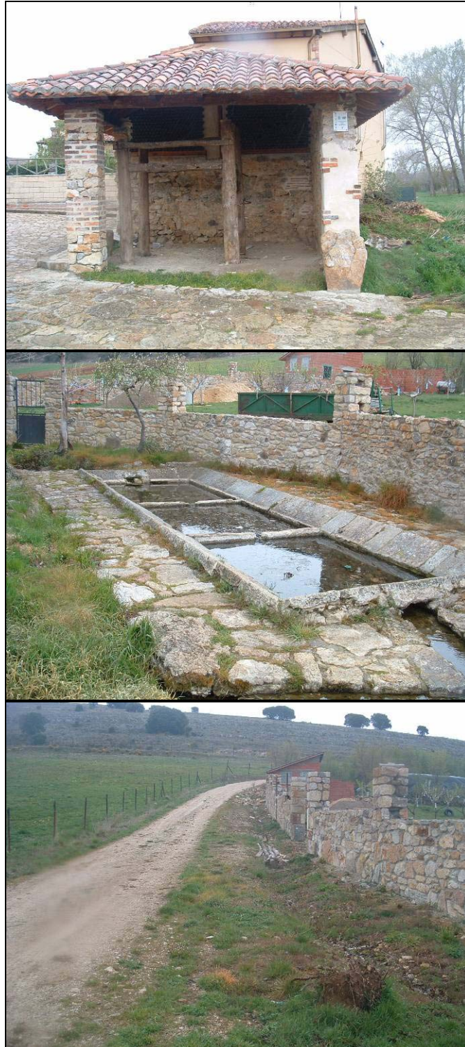
FOTOS 16-18: DIVERSAS VISTAS DE LOS SECTORES DE TARILONTE DE LA PEÑA
